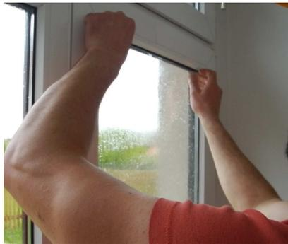
Mit dem Raker von der Mitte nach Außen verstreichen, hierbei von oben nach unten arbeiten, damit das Wasser und die Luft zwischen Klebefolie und Scheibe nach außen gedrückt werden.
