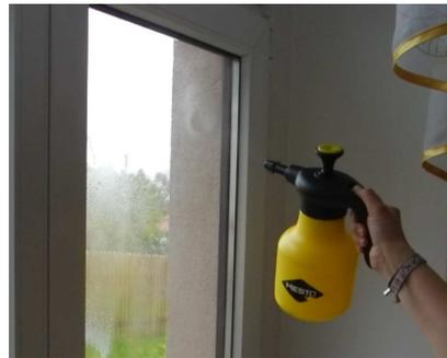
Die Klebefolie möglichst mittig auf der Scheibe anlegen und nochmals mit der Mischung großzügig besprühen.
